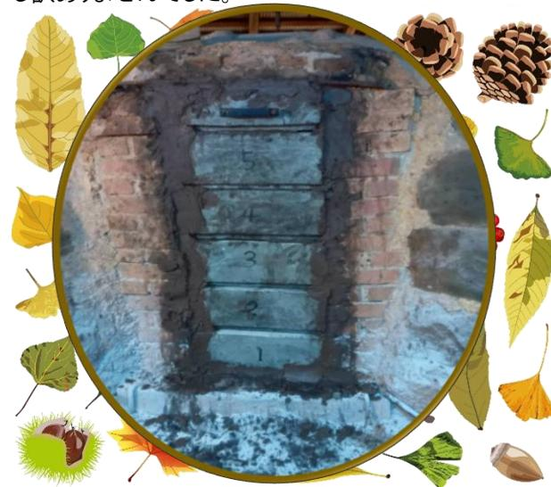
来年も毎月生産したいと思いますので炭材伐採薪割り作業等ご協力よろしくお願ひいたします。今回のトピックスは SIさんの考案による炭材入り口のブロック製作です。今まででは、15個の思いセメントを使っていましたが6個のブロックで密閉できるようになりました。また、焚口が劣化して土が落下しそうになっていたため補強しました。
