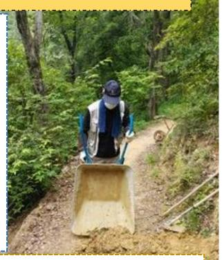
プレーパークからもう少し奥の地点、遊歩道わきの山側斜面が最近の雨で崩れて、道の半分くらいまで被さっていました。別の場所では、経時的な劣化で地面の土がえぐれて石が露出し、凹凸が激しい場所が点々としているため、その修復も兼ねて、6名で作業が行われました。
