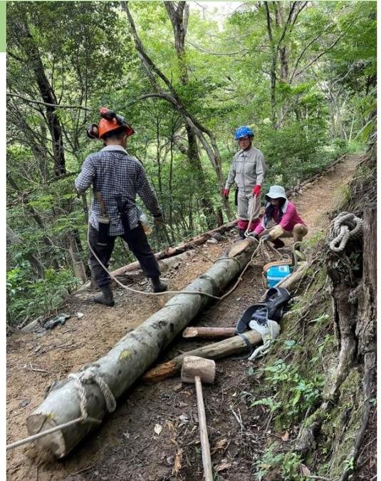
午後からは、遊歩道の整備を行いました。遊歩道の端の丸太が朽ちてきているのを新しい丸太へと変える、丸太がない場所には新しく丸太を置く作業です。丸太、ロープ、杭、クワ、かけや、チェーンソーなどを用いて行いました。切り出されて置いてある丸太にロープをかけて運んでくる人、道の端を少し掘って丸太に合う溝を作る人など、役割分担がなされてスムーズに作業が進んでいきました。
